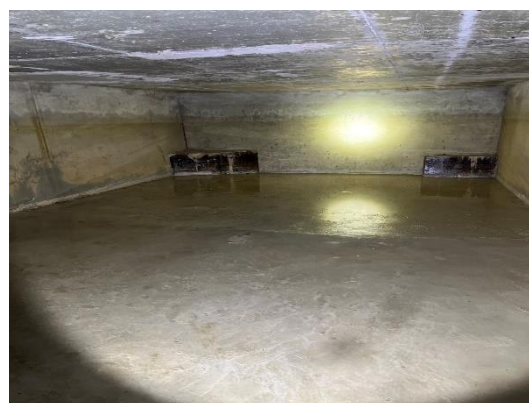
ภาพที่ 2-7 ถังเก็บน้ำใช้ และการล้างทำความสะอาดถังเก็บน้ำใช้
